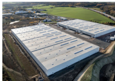
Fuchs Logistikzentrum Logistikfläche auf 70.000 m 2
