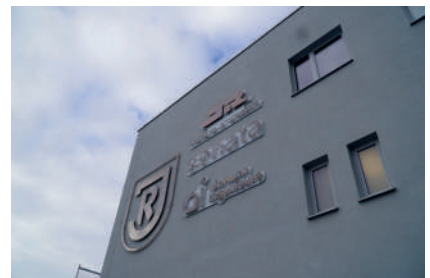
Funktionsgebäude SSV Jahn 3 Stockwerke auf 1.100 m 2
