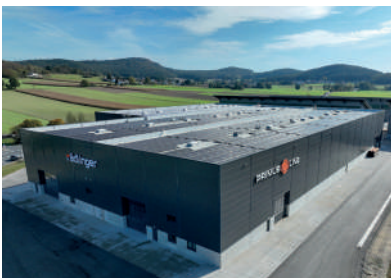
Primus Line in Chammünster Hallenneubau
